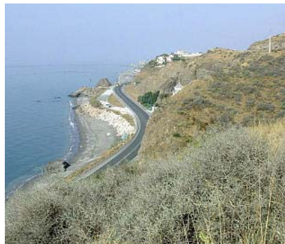
Calaceite. El hospital se construirá junto a la antigua travesía de la N-340, frente al 'Tajo de la Virgen'. F. E.
