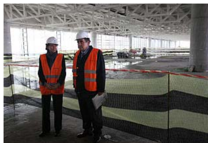
Terminal. La ministra Magdalena Álvarez, acompañada del secretario de Estado de Transportes, Fernando Palau, visitó ayer las obras del Aeropuerto. Arciniega
