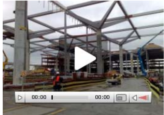
Obras en la ampliación del aeropuerto. / Salvador Salas
